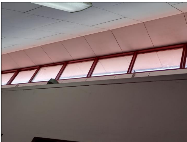
Anexo 7. Ventanas para iluminar naturalmente el edificio municipal
